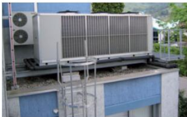
Изоляция системы кондиционирования
