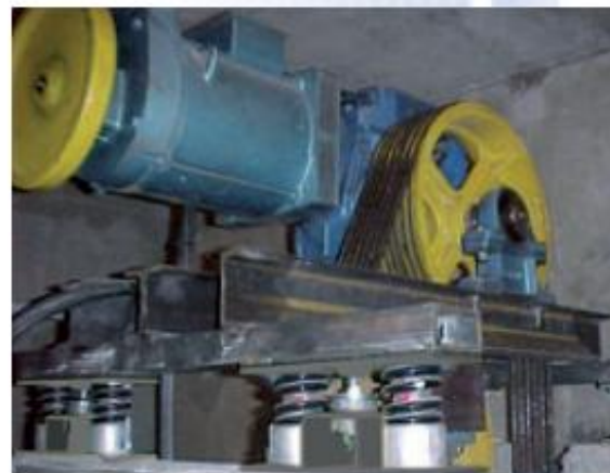
Виброизоляция привода лифта
